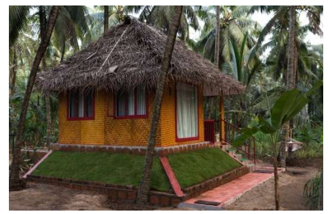
Bamboo Hut (2) situés dans la palmeraie
